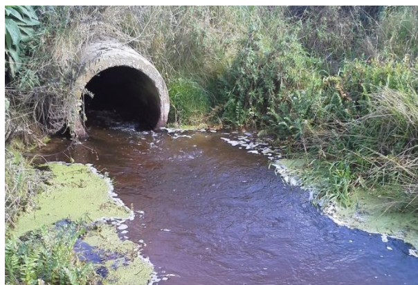
Rørbro der ligger med fald. Vandstanden kan hæves med grus på nedstrøms side, så både fisk og smådyr kan passere. Gruset skaber desuden en gydebanke og mindsker erosionen.
